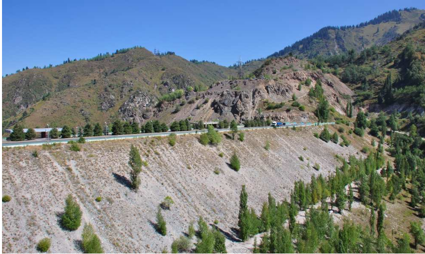
Рис. 3. Насипна ґрунтова гребля МЕДЕО у Казахстані, вона здатна затримати сіль об'ємом 12,6 млн м 3
