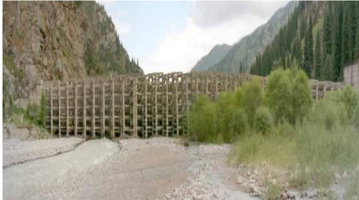
Рис. 5. Наскрізна селевлловлююча гребля із залізобетонних елементів
