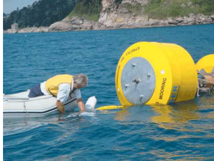
Рис. 3. Хвильовий насос перед закріпленням його на дні
