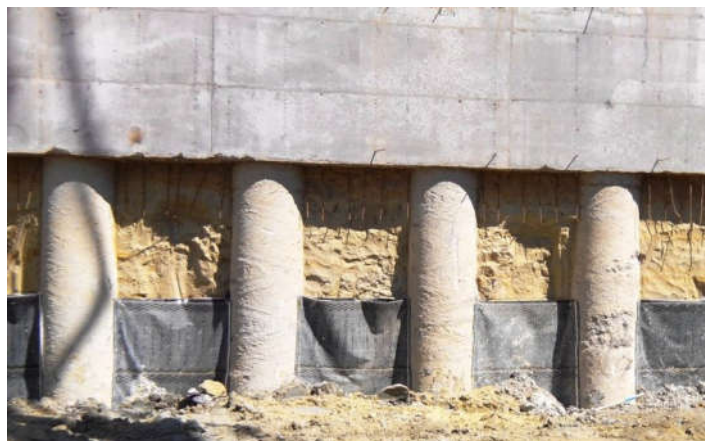
Рис. 8. Улаштування дренажної геомембрани між палями
