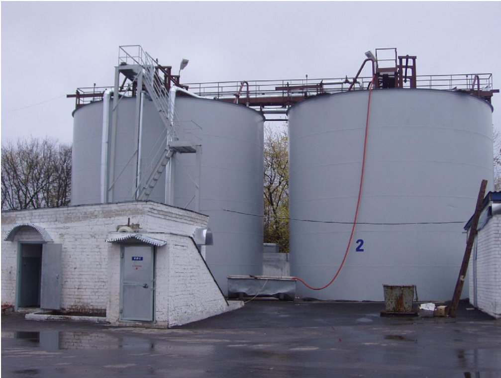
Рис. 3. Аеротенки-відстійники на очисних спорудах Шосткінського міськмолкомбінату
