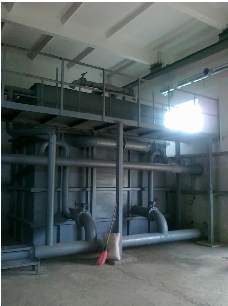
Рис. 5. Пінополістирольний фільтр для доочищення стічних вод забійного цеху
