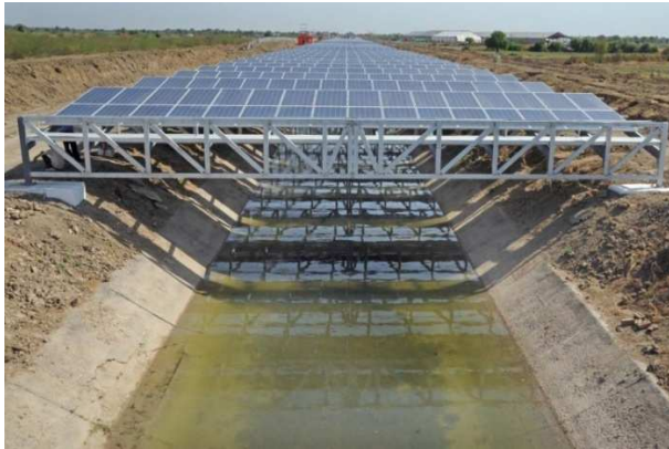
Рис. 7. Розташування сонячних батарей над зрошувальним каналом
