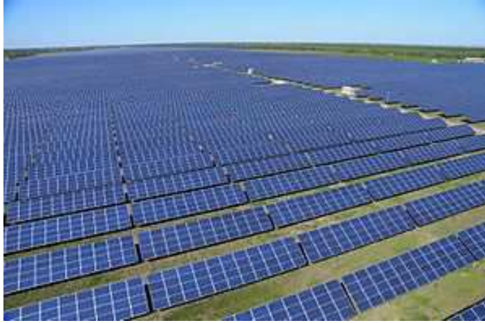
Рис. 1. Сонячна електростанція Старокозача, Одеська область
