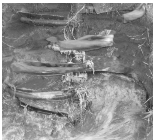
Рис. 8. Інтенсивний процес перемішування ґрунту до суспензного стану
