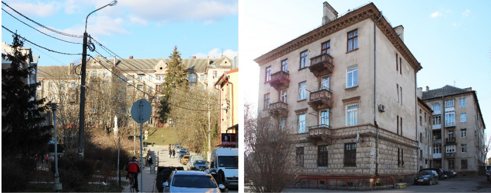
Рис. 1. Житловий будинок, Тернопіль, вул. Князя Острозького, 39/45
