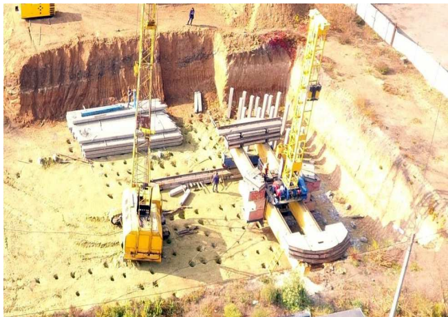
Рис. 2. Процес вдавлення паль на ділянці захватки № 1
