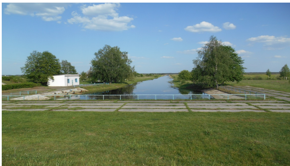
Рис. 1. Насосна станція осушувальної системи «Обірки» Сарненського району
