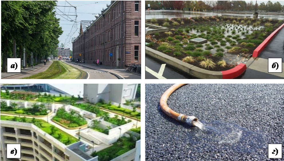
Рис. 3. Споруди фільтрувальних методів регулювання дощових стоків: а) газони і рослинні смуги; б) інфільтраційні басейни; в) «зелені» дахи; г) пористий асфальт
