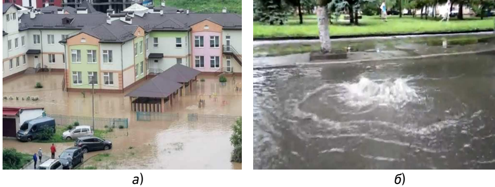
Рис. 1. Затоплення міських територій: а) за відсутності колекторів дощового водовідведення; б) через мережі дощового водовідведення при роботі їх у напірному режимі
