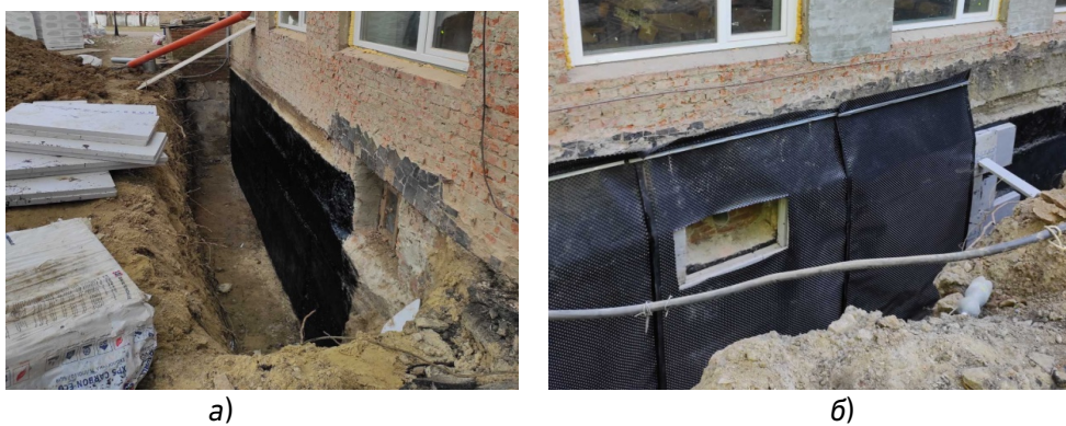
Рис. 3. Фото робіт по гідроізоляції та утепленню стін, що межують з ґрунтом: а) гідроізоляція мастикою у два шари; б) улаштування екструдованих полістирольних плит із захисною мембраною
