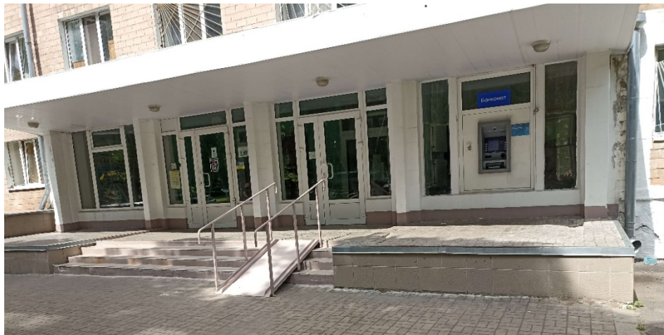
Рис. 1. Вхід у гуртожиток університету до капітального ремонту
