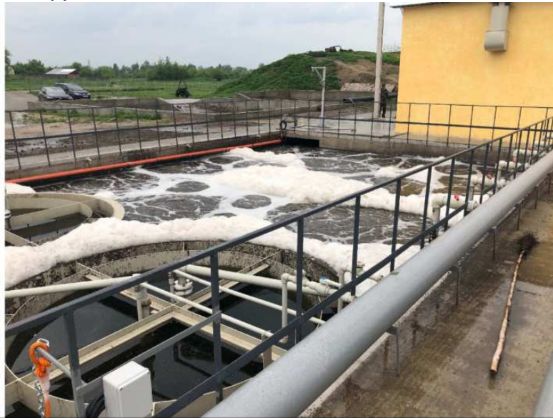
Рис. 6. Аеротенки очисних споруд міста Чортків
