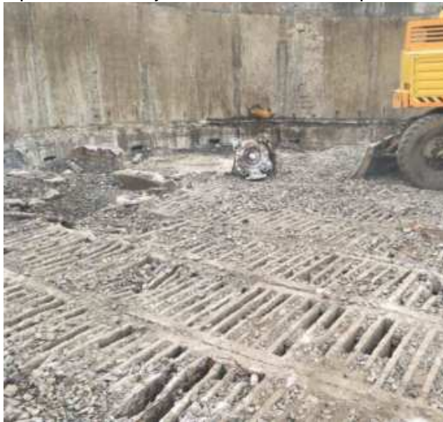
Рис. 2. Вивантаження завантаження і демонтаж дренажу біофільтра
