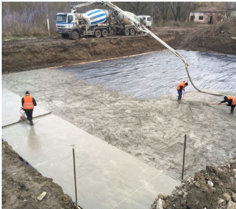
Рис. 4. Підготовка основи під комбіновані аеротенки
