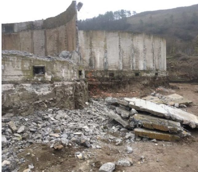
Рис. 3. Демонтаж стін біофільтра
